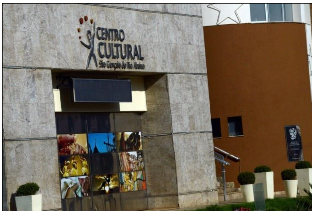
Figura 61: Centro Cultural de São Gonçalo do Rio Abaixo. Fonte: Fabio Lima - Arquiturismo (2016).
