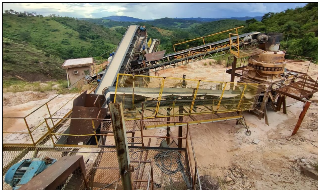
Figura 45: Vista dos equipamentos da área de beneficiamento. Fonte: Ecolabore Engenharia (2024).
