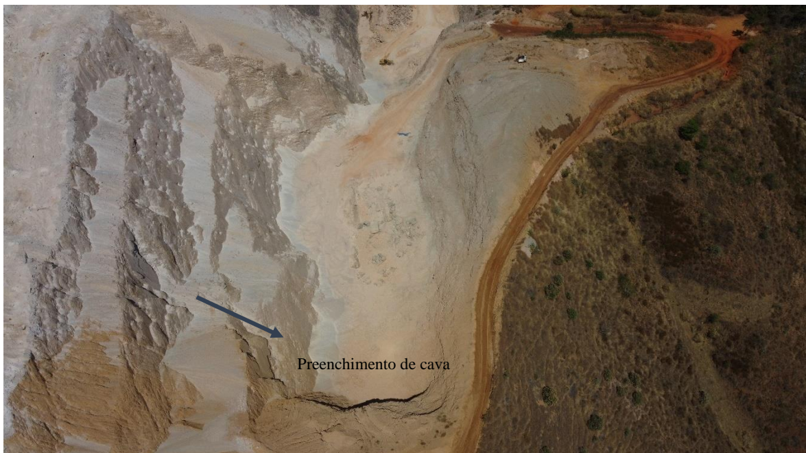
Figura 38: Foto da vista aérea do Preenchimento da Cava Fonte: SPE / MAQ (2024).
