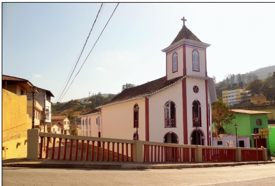
Figura 121: Igreja Nossa Senhora do Rosário dos Petros, localizada na Av. João Soares da Silva, no bairro Penha, Itabira/MG.
