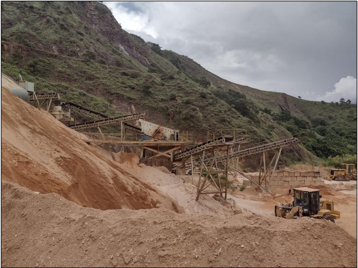
Figura 46: Vista dos equipamentos da área de beneficiamento. Fonte: Ecolabore Engenharia (2024).
