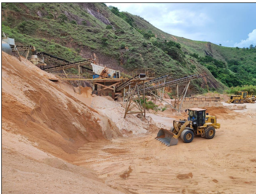
Figura 30: Vista da área operacional do empreendimento. Fonte: Ecolabore Engenharia (2024).
