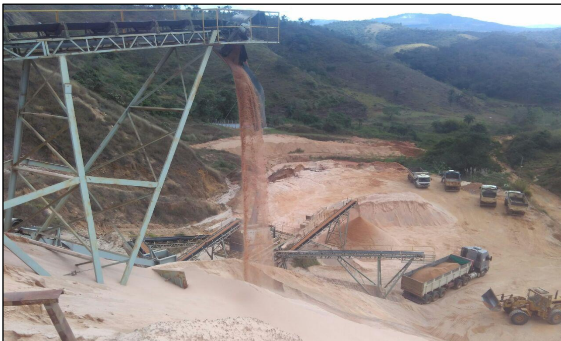
Figura 44: Área de beneficiamento e carregamento de caminhões. Fonte: SPE / MAQ (2020).
