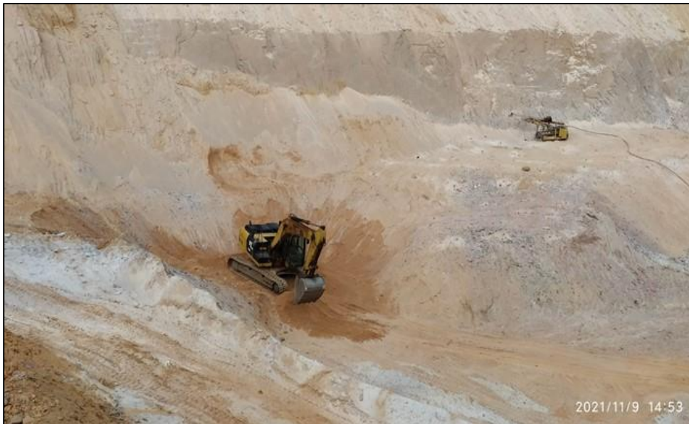
Figura 24: Escavadeira Caterpillar em operação na frente de lavra.
