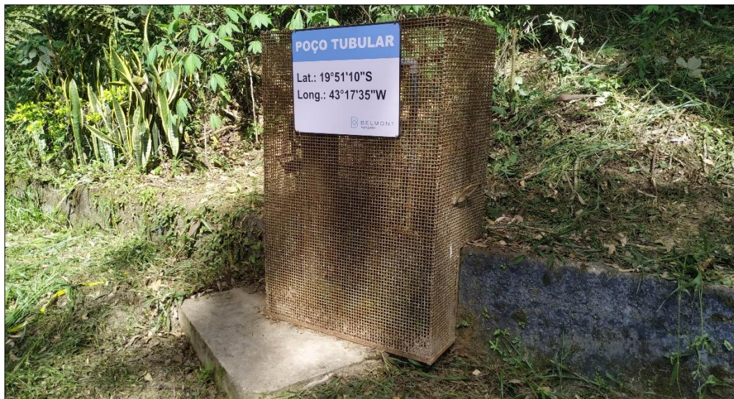
Figura 33: Poço tubular para captação de água subterrânea para consumo humano. Fonte: Ecolabore Engenharia Ltda (2024).
