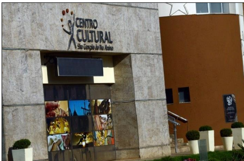
Figura 94: Centro Cultural de São Gonçalo do Rio Abaixo. Fonte: Fabio Lima - Arquiturismo (2016).
