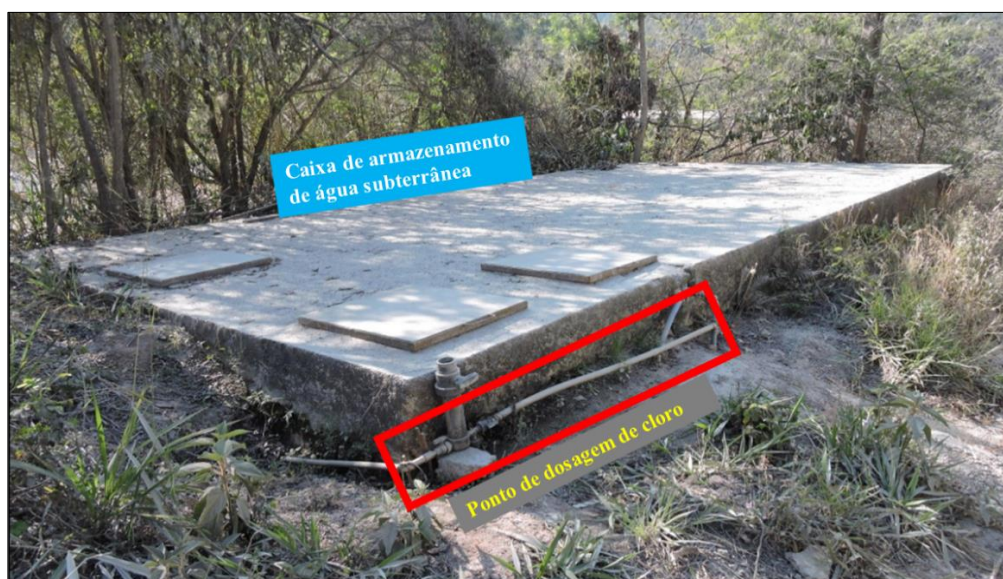
Figura 34: Ponto de dosagem de cloro no poço tubular para captação de água subterrânea para consumo humano. Fonte: Ecolabore Engenharia Ltda (2022).
